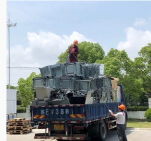
高空作业改善前
