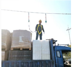
高空作业改善后
